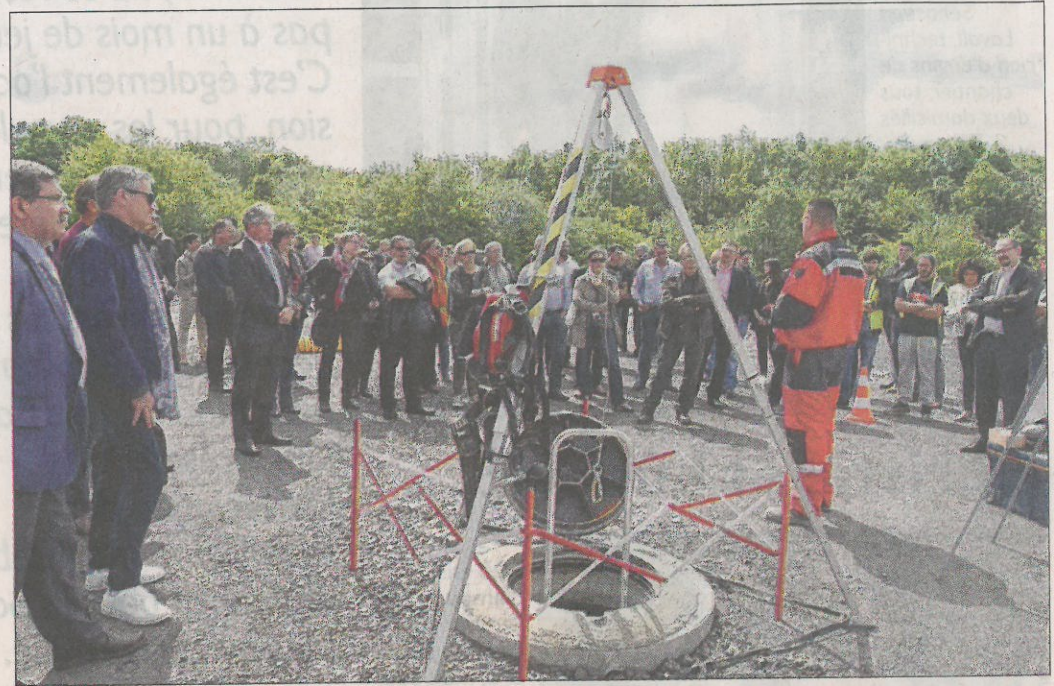
Le public était convié à visiter le nouveau réseau-école mais sans passer par ce tampon ouvert. Photo RL
